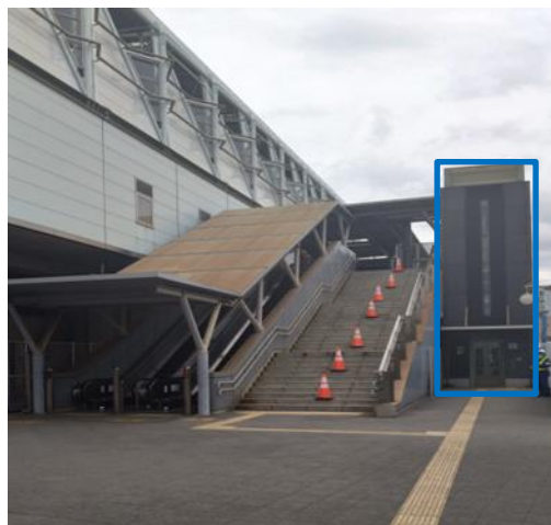
搬出入EV(土塔出口EV)
