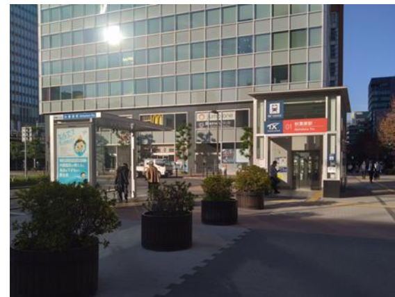
搬出入EV(交通広場)
